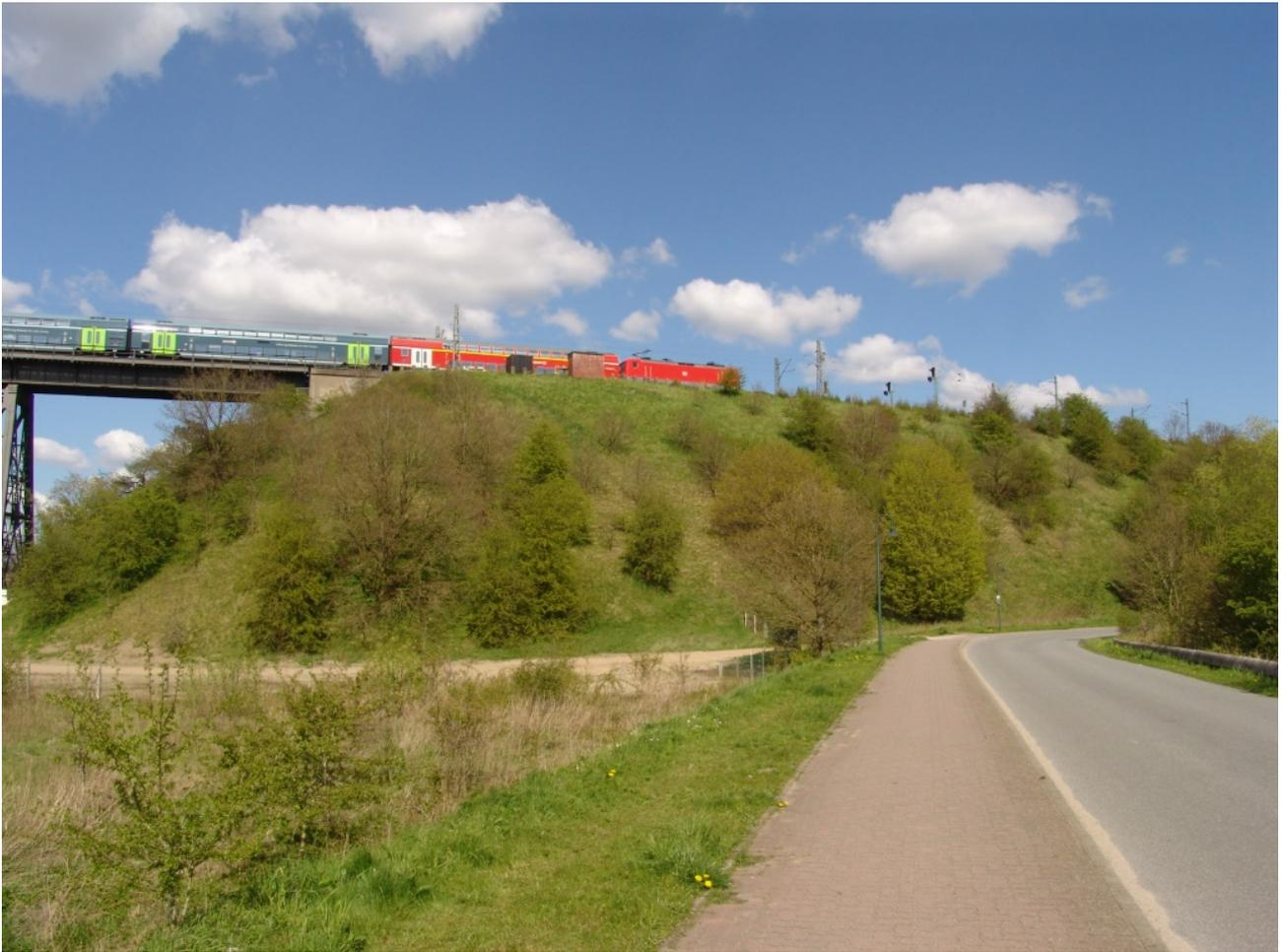
Abb. 289-02: Eisenbahndamm am Nord-Ostsee-Kanal bei Osterrönfeld. Die Dammhöhe beträgt 26 m und die Sohlbreite 100 m (DTK 25, Blatt 1724 Bokelholm), Foto: H. KAUFHOLD 2016
